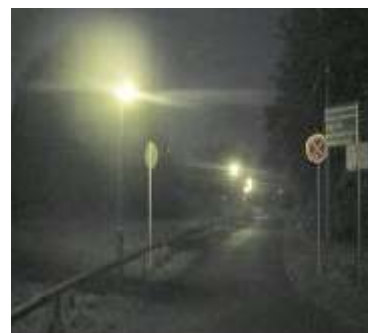
Oświetlenie solarne LED w gminie Großkrotzenburg w powiecie Main-Kinzig
